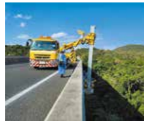
橋の点検作業
