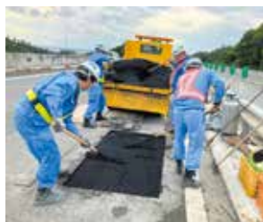
道路舗装工事
