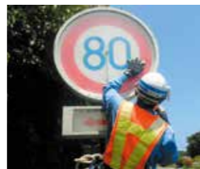
規制標識の点検作業
