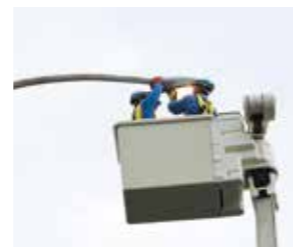
道路照明取替作業
