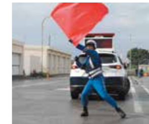
旗振りによる誘導作業
