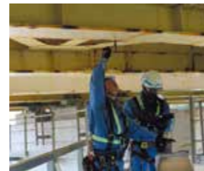
橋の打音点検
