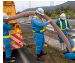
泥やゴミの排水管清掃
