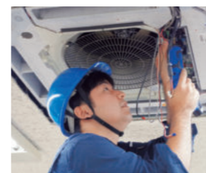
エアコン整備
